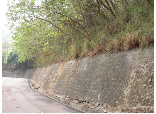
鳳山水庫現場環境，道路
