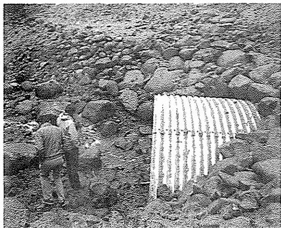
圖五 公路施工單位興建的魚道
