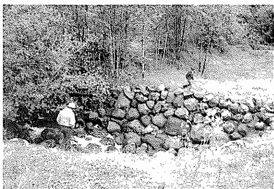
圖十七 穩固堤岸之岩石構造
