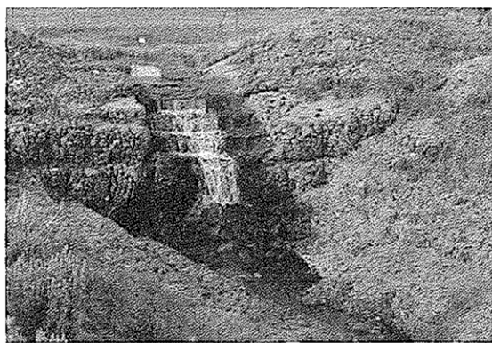
圖廿 爲保存固有魚種棲地防止外來魚種侵入所設之障礙壩(Fish Barrier)
