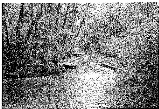
圖十五 溪中安置之護岸原木， 可避免水流冲蝕堤岸又可 創造水潭及罩蓋
