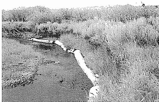
圖十四 河岸植草工程
