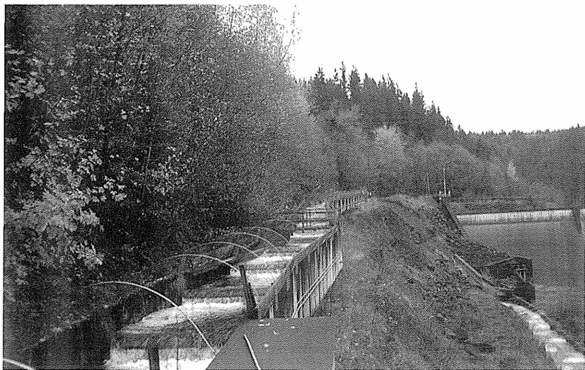
圖二 美國哥倫比亞河上的魚道 全長 2 英里，跨越二個大 型水壩
