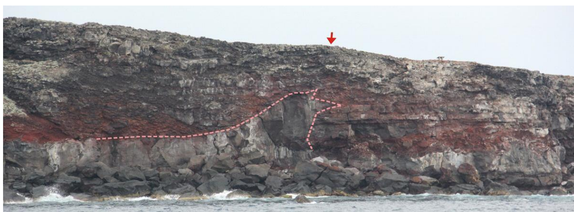
圖 4.5.13 伸張破裂型的拱面-1
