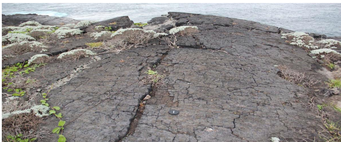
圖 4.5.14 伸張破裂型的拱面-2
