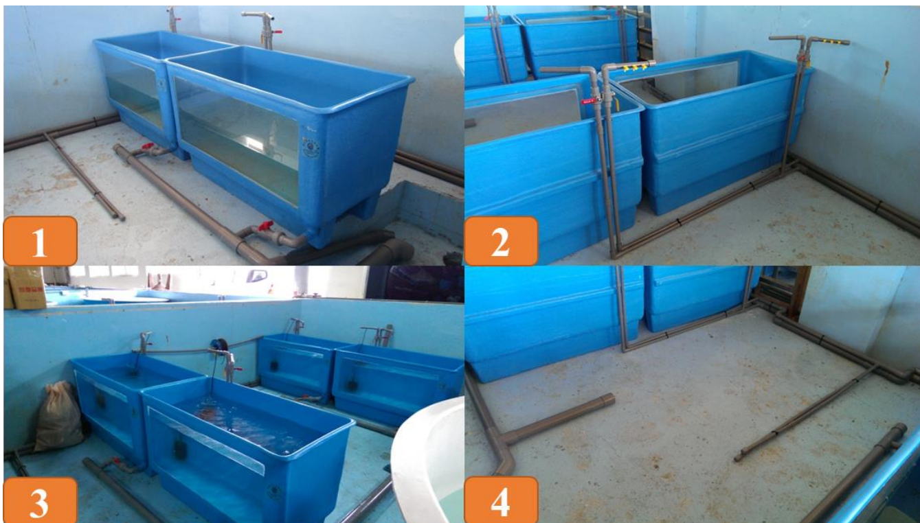
圖 6、繁殖缸建置 1.排水系統 2.進水管線及出氣管線 3.完成實體照 4.預留管線
