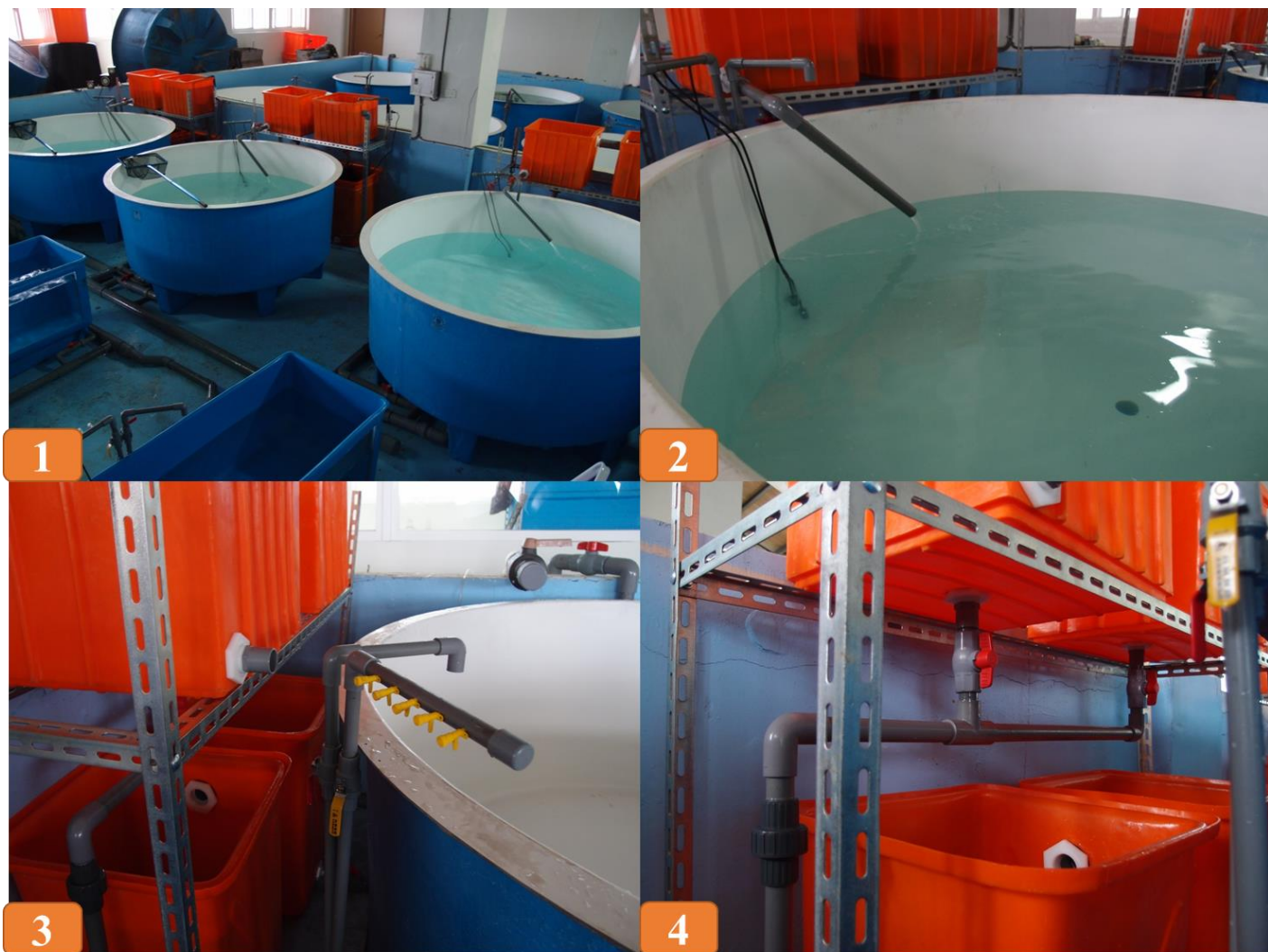
圖 5、循環系統缸建置 1. 完成實體照
