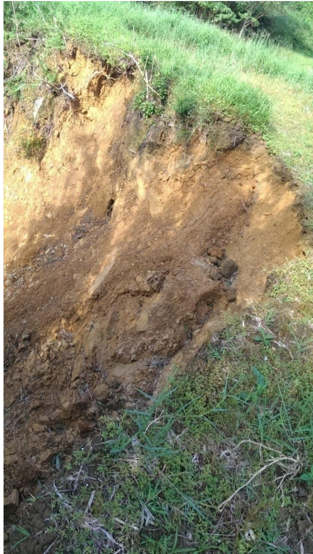
圖 4.5 水梯田休耕後邊坡崩塌之情形
