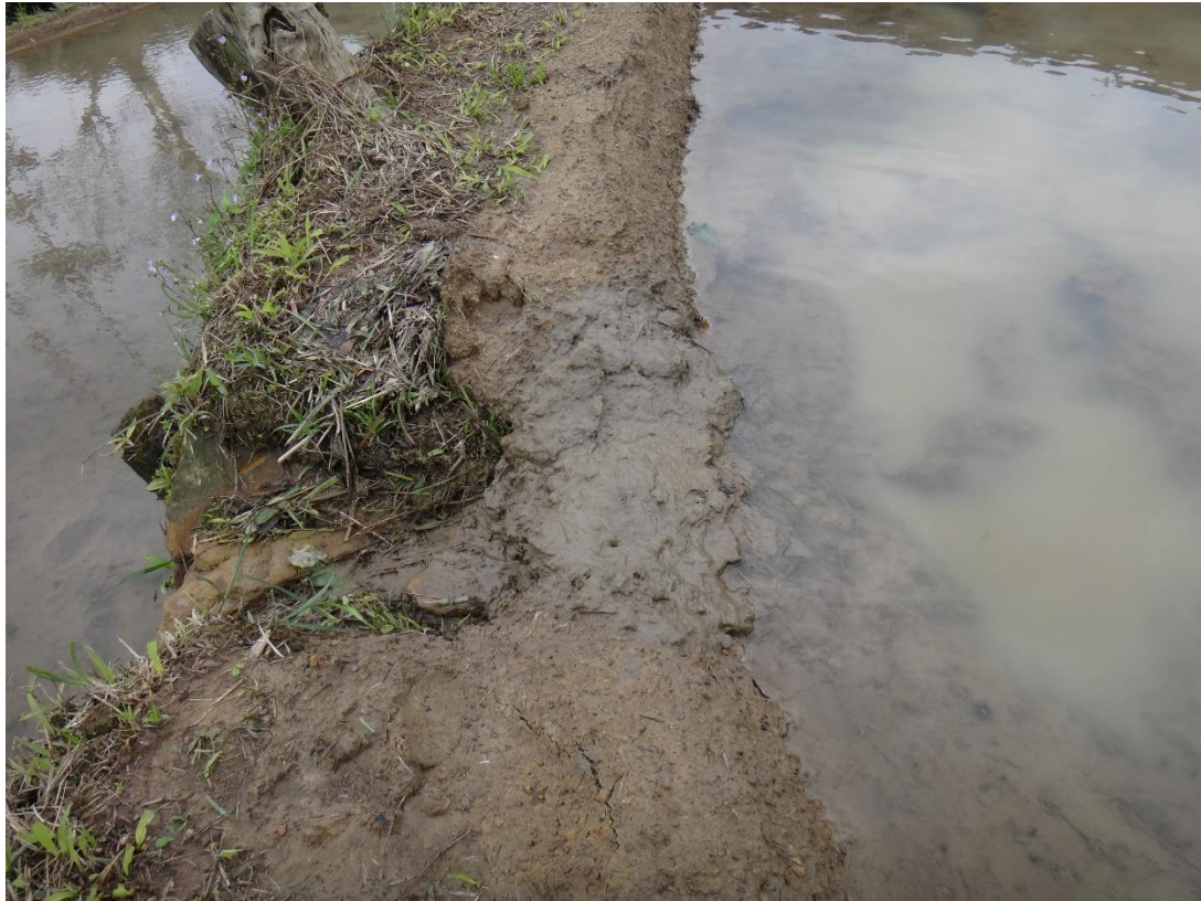
圖 3.12 田埂缺口填補
