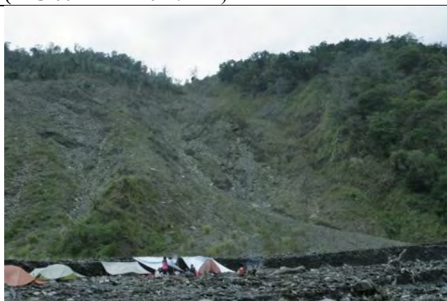
(9) 馬里山溪支流旁的崩塌 (N22°59'48" E120°45'13")
