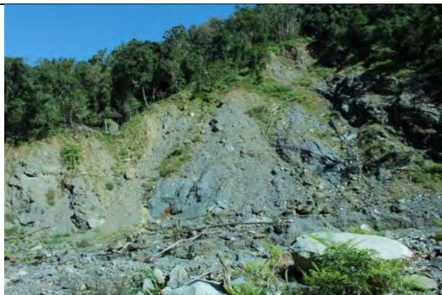
(1) 林道崩塌 (N23°02'01" E120°47'15")
