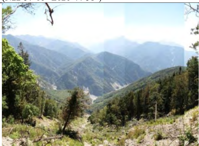
(15) 林道崩塌 (N22°58'12" E120°45'54")
