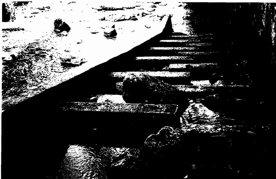
圖7、魚道內石塊、樹枝或人為垃圾阻塞水流，也限制魚蝦的上溯。台北縣三峽熊空溪。
