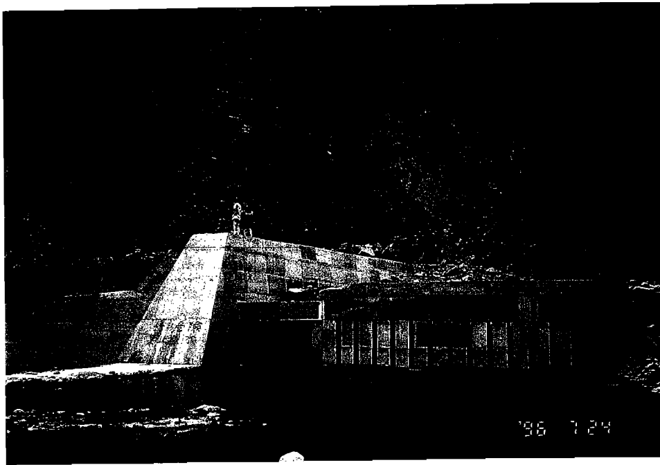
圖13a、現存的魚道結構已有許多改進結構，如在上游出口有柵狀構造以防止巨石進入魚道。苗栗縣泰安汶水溪。
