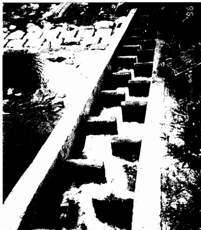
圖4、隔板距離太近無加速區，魚無法有效加速來躍過魚梯。台北縣烏來加久寮溪。
