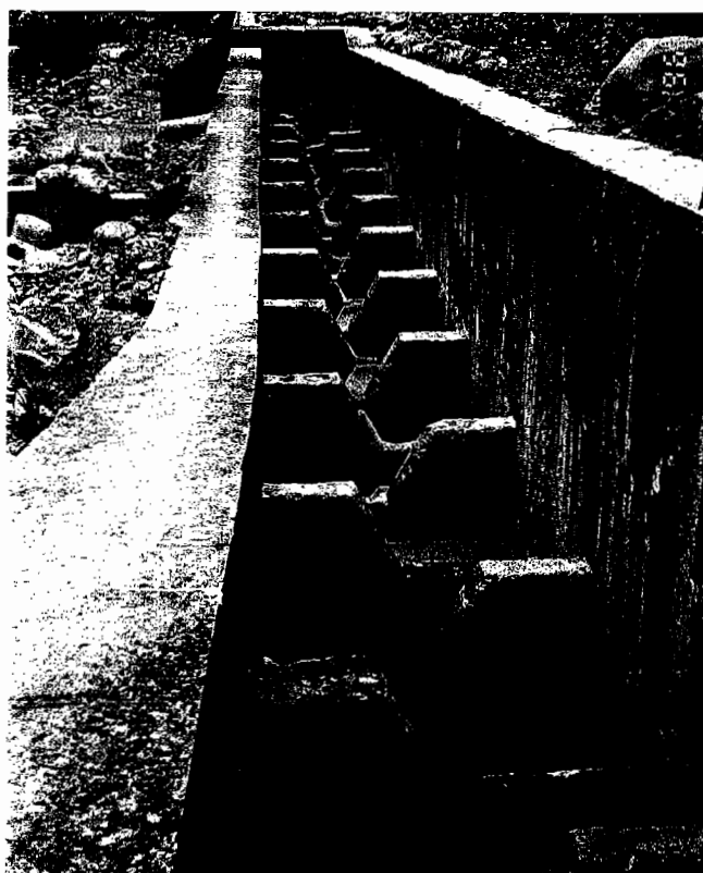
圖8、道內水流量沒考慮到豐水期及枯水期的水量變化，影響到魚道的利用。苗栗縣南庄上港溪。
