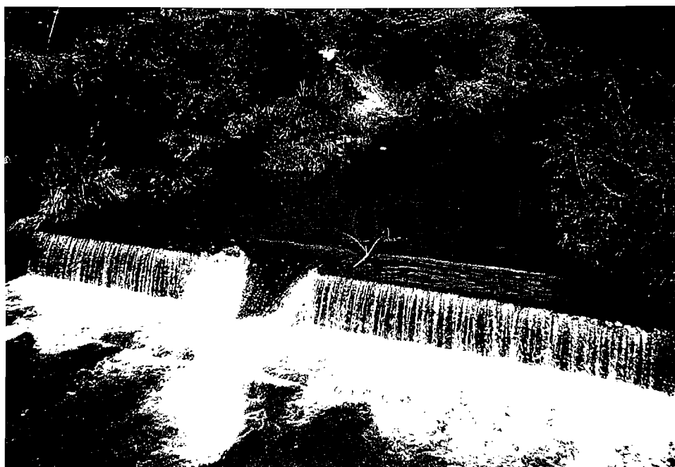
照片3、攔砂壩中央開缺口當魚道。
