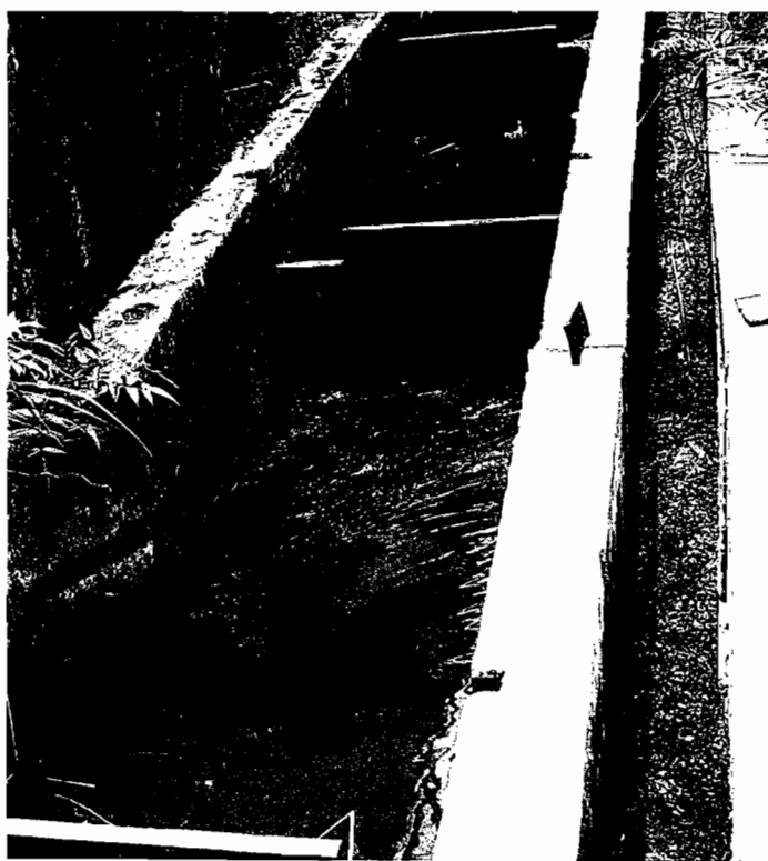
圖3、隔板落差過大，魚無法躍過。台灣魚種的體型較小，不若鮭鱒魚類因體型大能輕易躍過50公分的高度。台北縣金山鹿角坑溪
