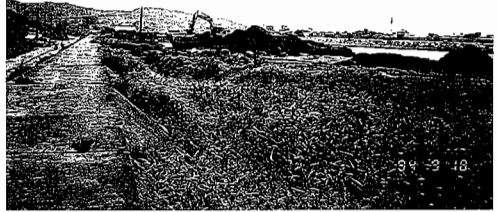
立農站：河岸挖土施工情形（葛世良攝）
