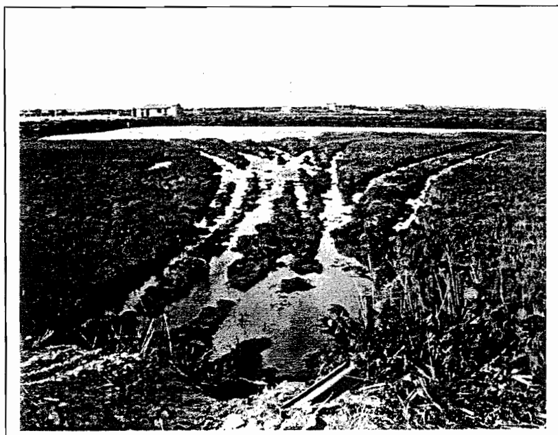
圖 4.7 在水雉區挖好的深水池，由於整區施工尚未完成，現場稍嫌凌亂，目前只有鷺科鳥類在這裡出現。
