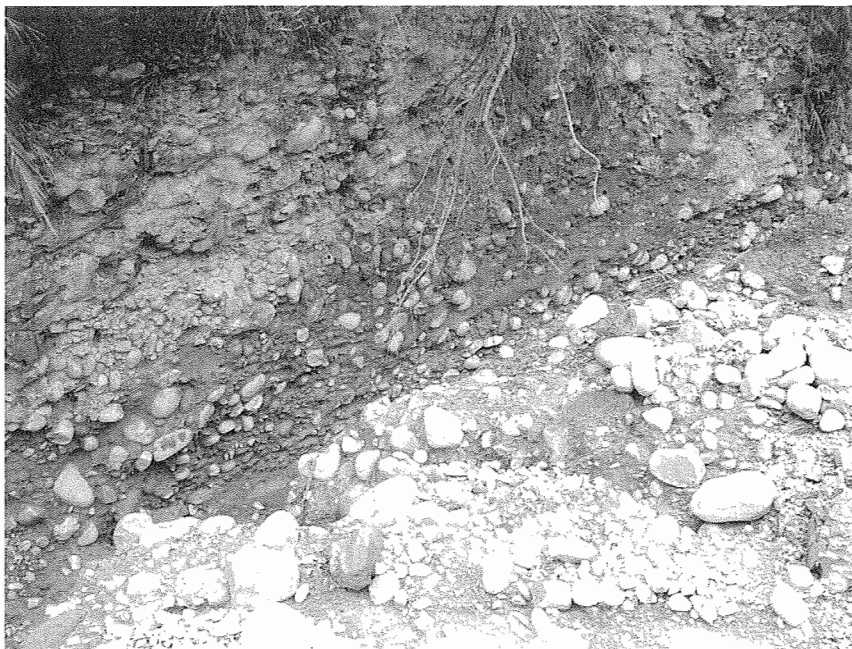
照片 2-2 由邊坡崩落的礫石與泥沙是沖積扇物質的主要來源
