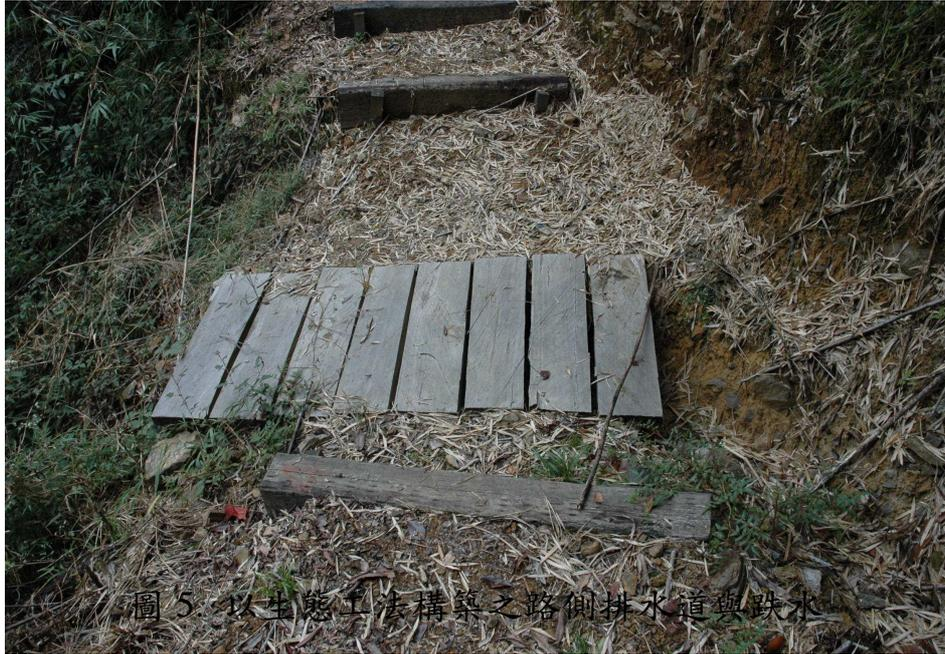
圖 5 以生態工法構築之路側排水道與跌水
