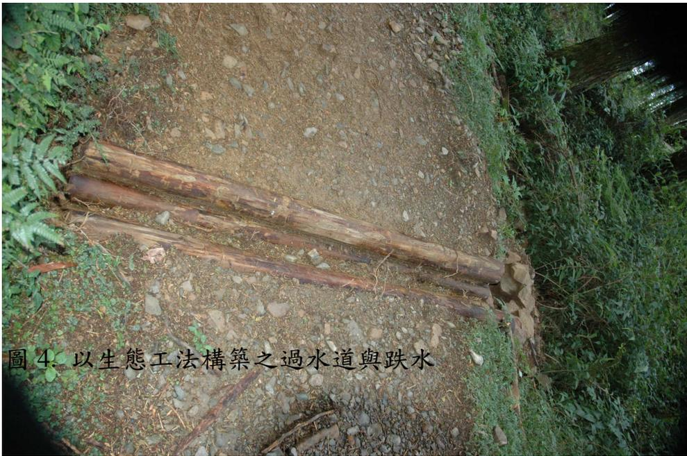
圖 4. 以生態工法構築之過水道與跌水
