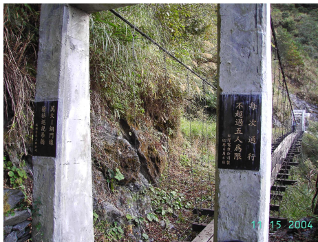
附圖 4. 堅固的檜林巡視吊橋
