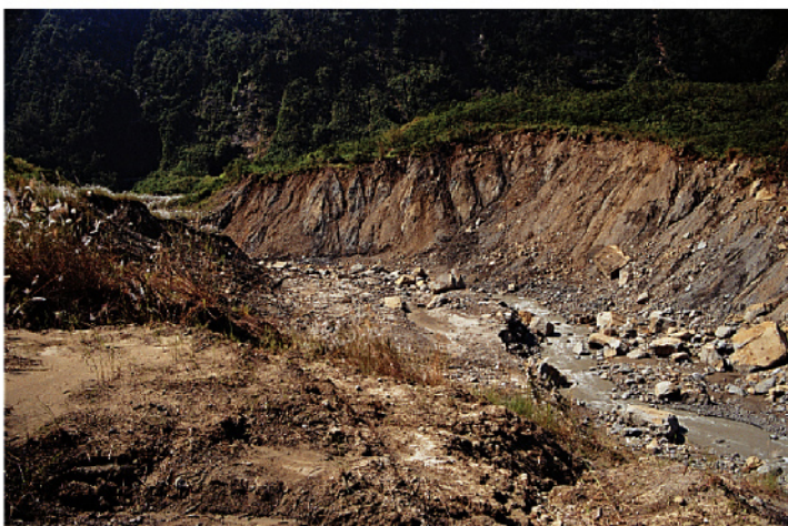
◀◀ 照片4：新草嶺潭在民國93年7月2日淤滿，同時沖毀原有的出口土壩，引發清水溪深切出口處河床。
