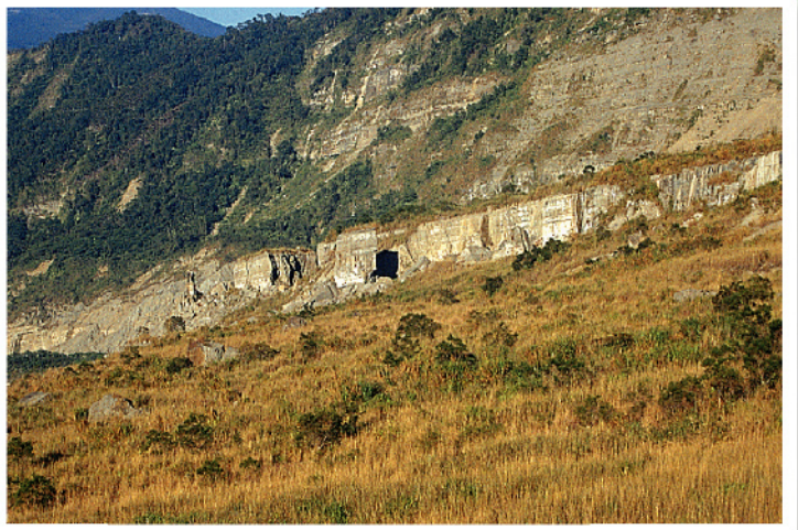
▶▶ 照片1：草嶺山崩的前端崩崖仍不斷地崩塌，地質仍不穩定。
