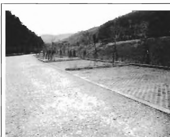
停車場(採用符合生態工法的透水鋪面)
