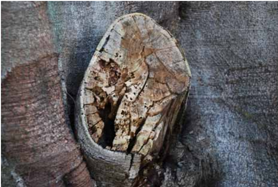
圖八：蟲蟻的入侵助長木材腐朽的嚴重性。
