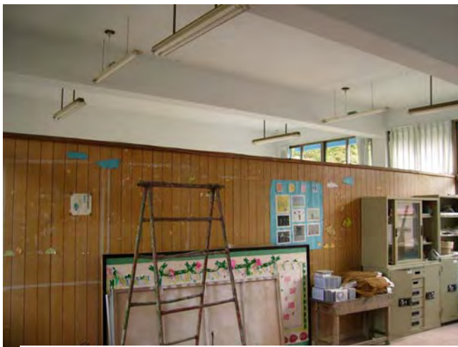
舊教室內部保存狀況 1
