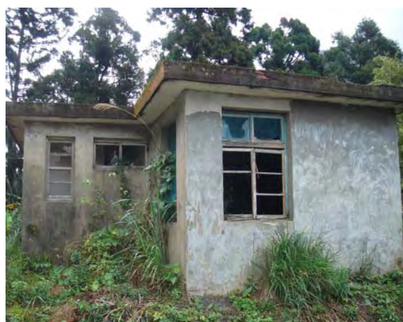
護管所外觀現況 2
