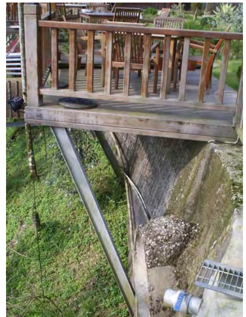
木棧道鋼構斜撐架設示意
