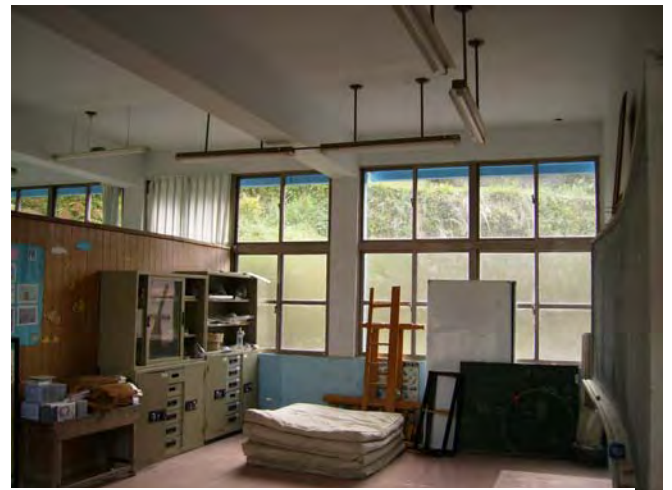
舊教室內部保存狀況 2
