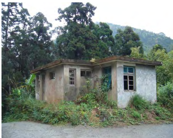
護管所外觀現況 1
