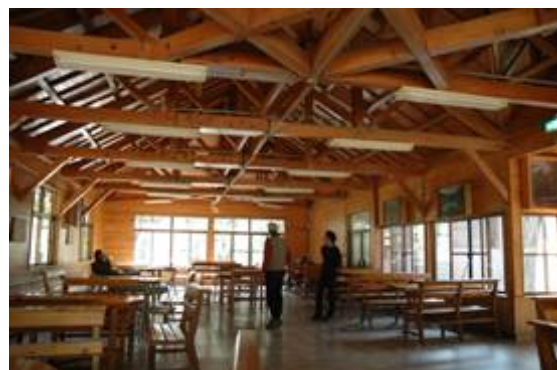
■早期所建造之木構造建築目前尚能保存其原始風貌，在其結構安全無虞下，可重新賦予新的使用價值。圖為奧萬大森林遊樂區松林步道中繼站
