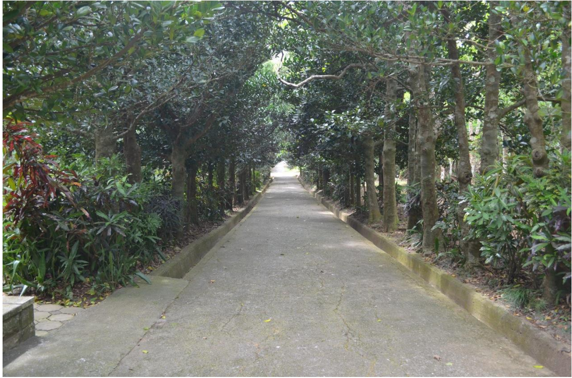
圖 5.32 道路上的裂縫
