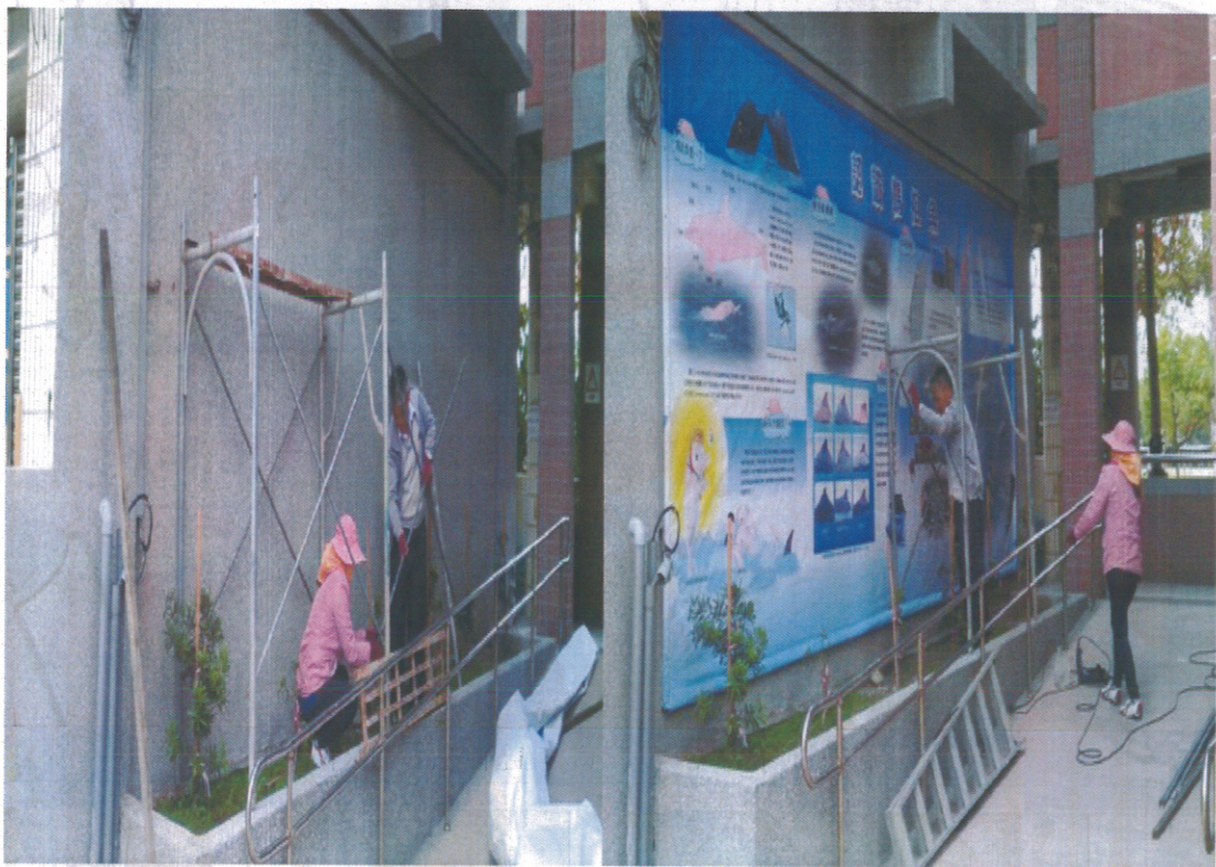
設置於雲林縣海洋教育中心的白海豚解說看板(左:施工前,右:施工後)
