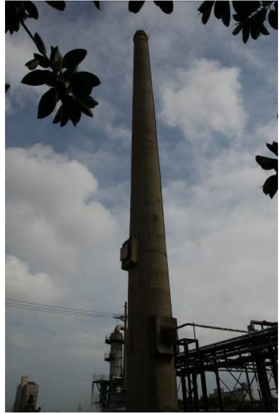
照片 3. 台肥公司的廢棄煙囪
