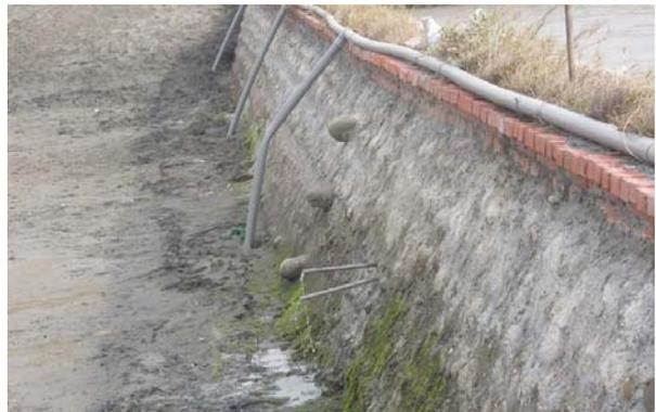
▲(圖) 隔池牆地基灌混凝土：因隔池牆地基處不水，緊通知混凝土來灌。南側壁體也因不水，泥作師以防水快水泥試作。(圖) 壁體防水：泥作師來看防水試作的情形，仍會水，決定在壁體內打入水管做為引流管。
