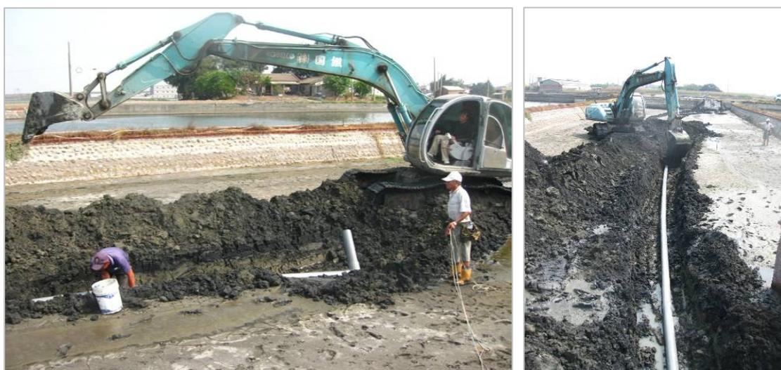
▲挖土機挖排污管路及陰井、進排水路配置：挖陰井，深度4尺，有多處出水，以一台2.5inch的抽水幫來抽水。工頭建議陰井不能磚，改成混凝土。
