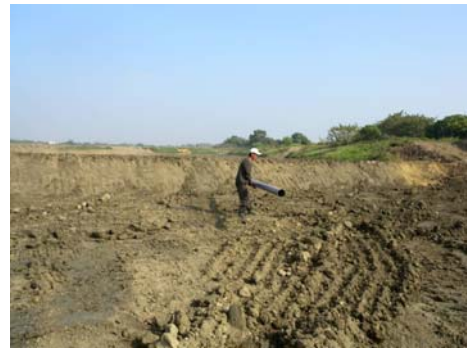
9 號池埋設排水管
