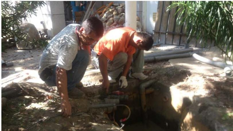
圖六：放流水系統測試
