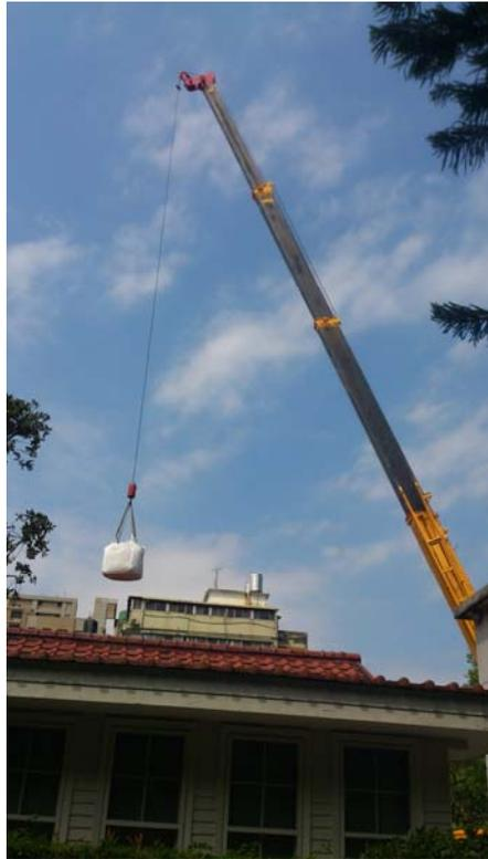
圖一：以吊車吊掛土方石材入場
