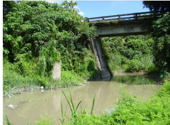
圖 1-2、第二季長寮埔橋
