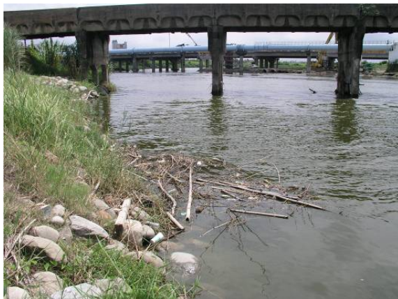
圖 11-2、第二季二層行橋
