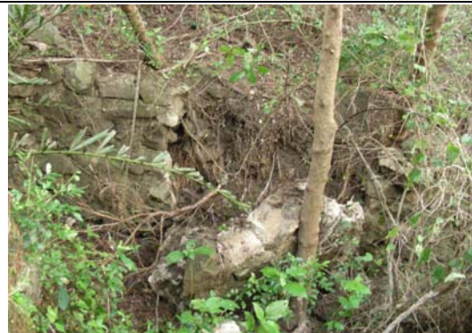
照片 2 墾丁大圓山廢棄碉堡旁坍塌土牆
