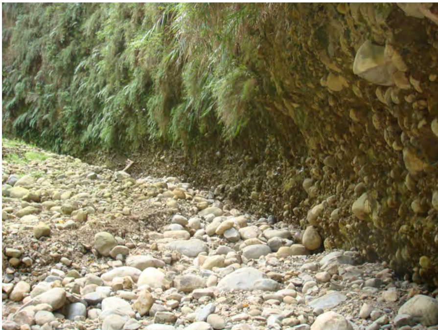
圖 47. 河道侵蝕（乾溪支流）
