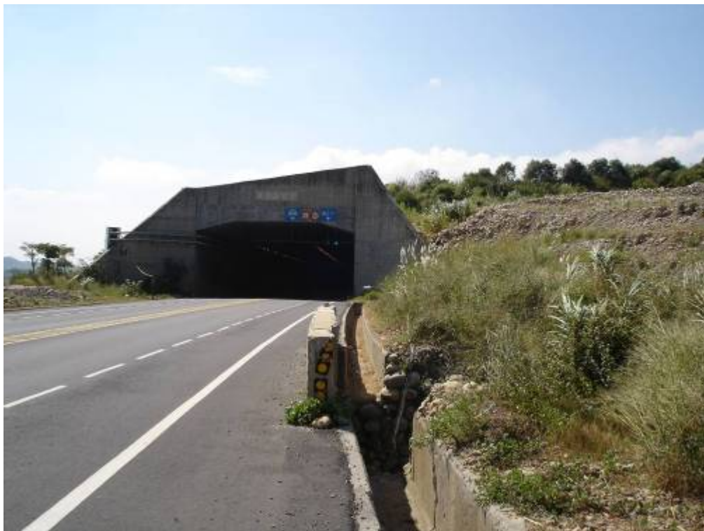
圖 5.30 莫拉克颱風後火炎山隧道東口邊坡情況
