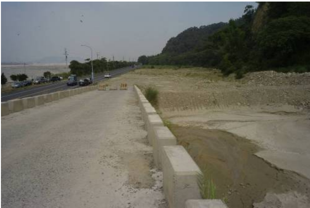
圖 5.23 從土堤往下看，土堤內側有一小土堤
