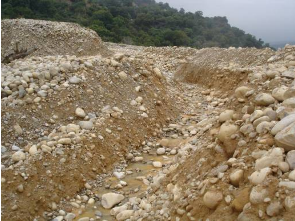
圖 6.27 3 號集水區上所挖掘的溝渠
