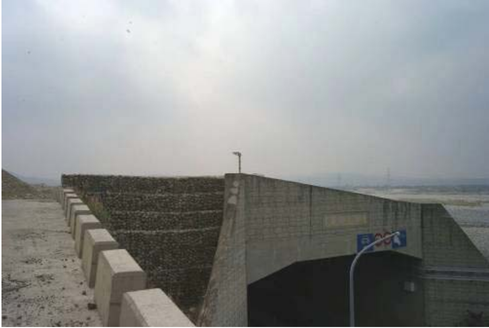
圖 5.24 本計畫在隧道西口設立的影像監視器
