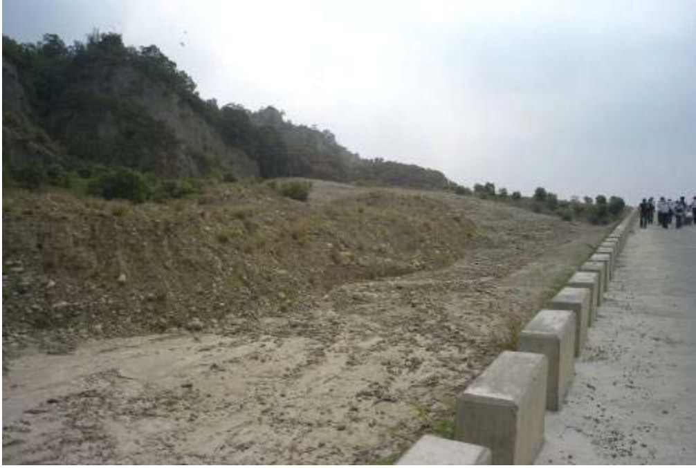
圖 5.22 隧道西口土堤內側土石堆積情況
