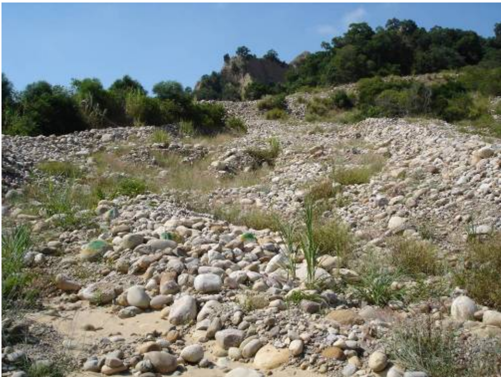
圖 5.32 莫拉克颱風後火炎山隧道東口旁土石流痕跡
