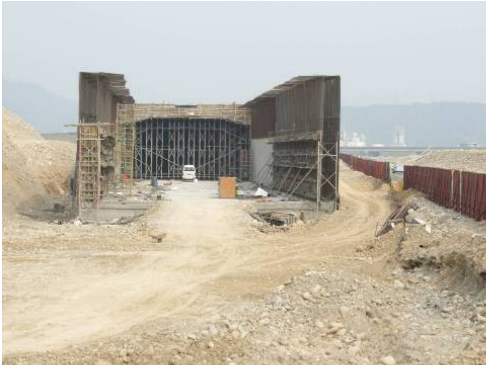
圖 2.7 施工中的火炎山隧道口（拍攝日期：2005/4/5）
