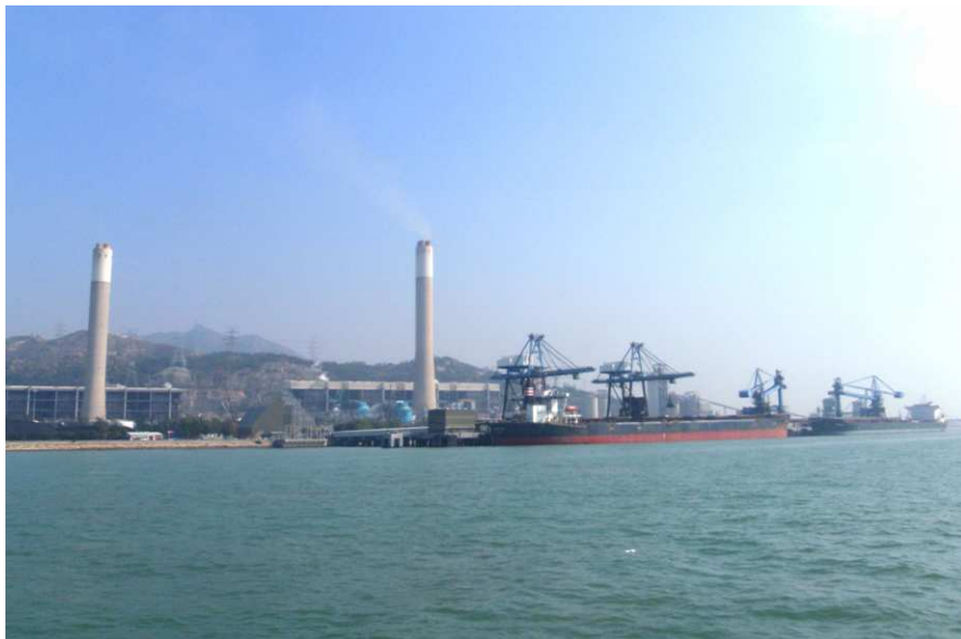
照片 1：香港白海豚保護區外附近的發電廠。
