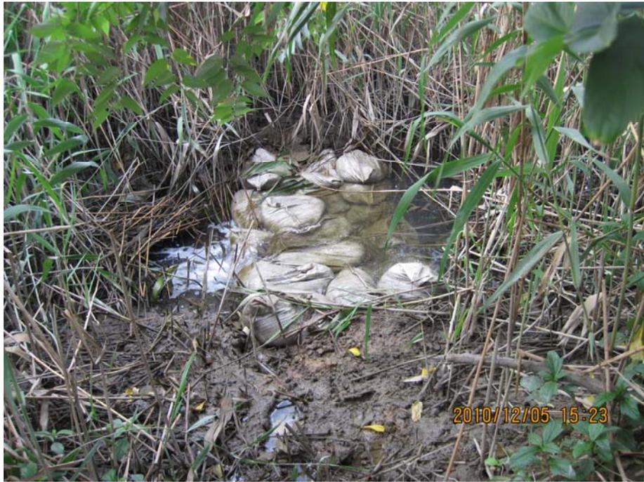
圖 4.3.2-9 南蘆葦叢西側池土袋堆疊與施工後積水情形
