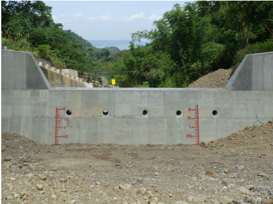
圖 45. 埔里事業區第11林班坑口溪上游攔砂壩壩體，標示高度
