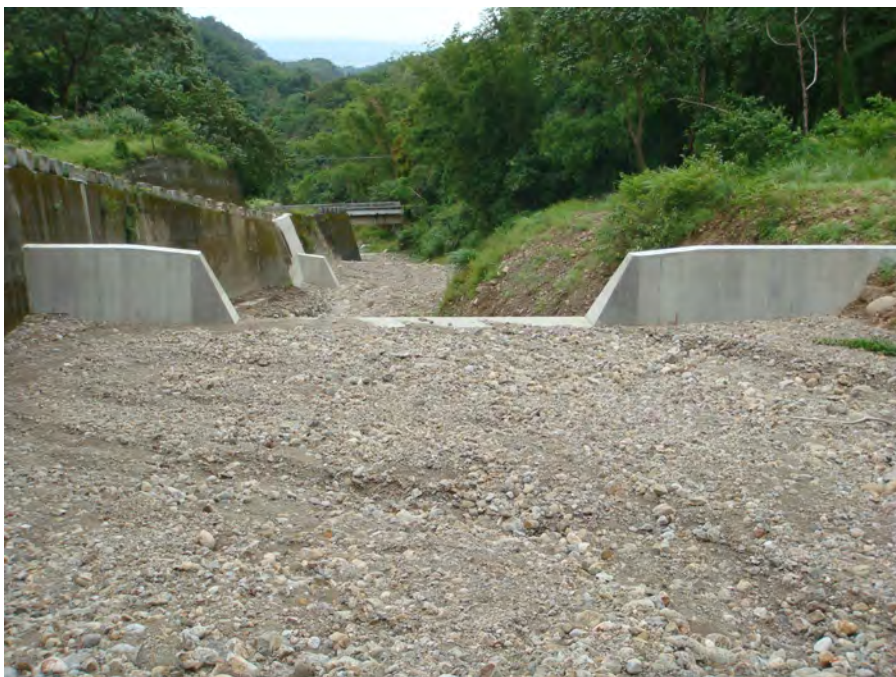
圖 46. 8 月份莫拉克颱風後，8/10 觀察整座壩體已被填滿
