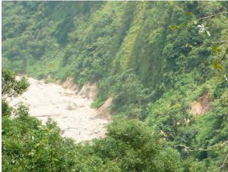
圖 34 乾溪上游河岸側蝕所產生的小規模崩塌及岩層裸露（226973,2656046）
