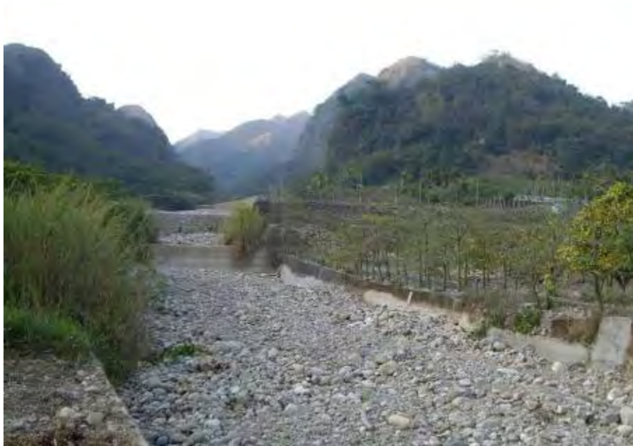
圖 32 田尾坑溪下游攔砂壩堆積情形 (229778,2654944)
