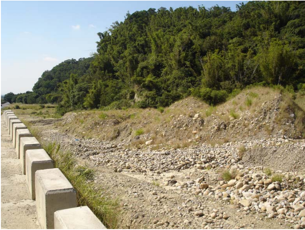
圖 67 隧道西口旁的滯洪池
