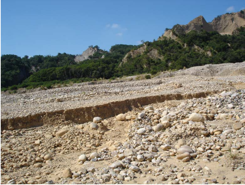
圖 60 三號集水區扇面上的刷深情況
