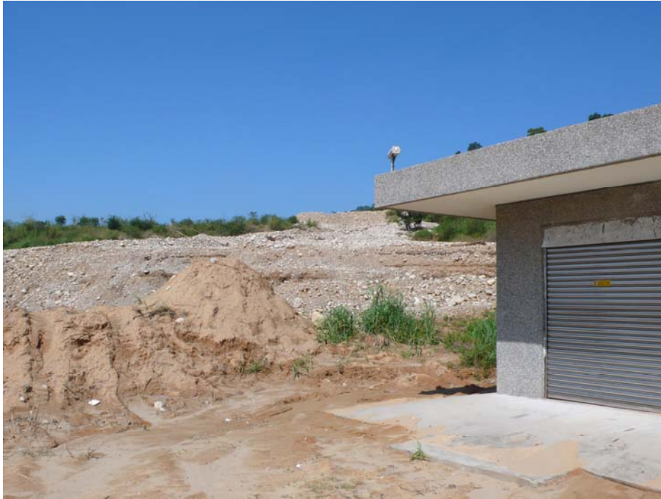
圖 21 2008 年辛樂克颱風後隧道東口處照片 (2008.10.09)
