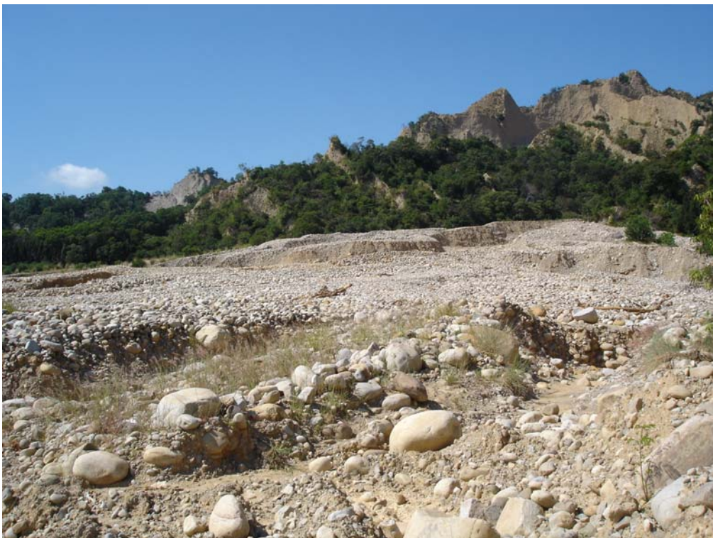
圖 57 莫拉克颱風後火炎山三號集水區情況，遠處可見河道的刷深高度
