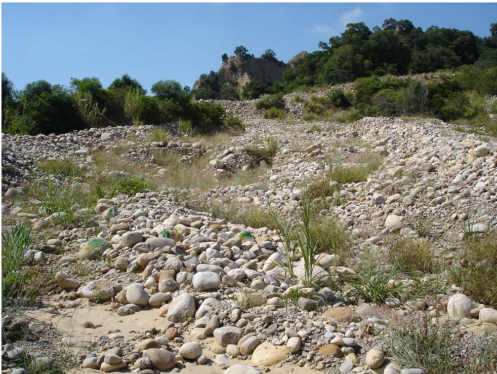
圖 54 莫拉克颱風後火炎山隧道東口旁土石流痕跡
