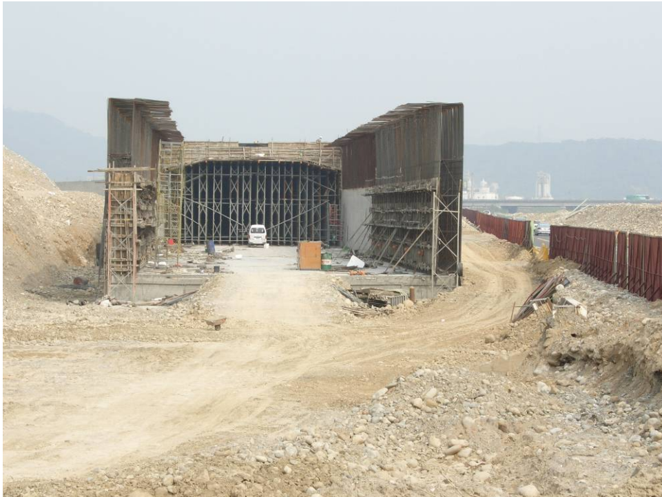
圖 7 施工中的火炎山隧道口（拍攝日期：2005/4/5）
