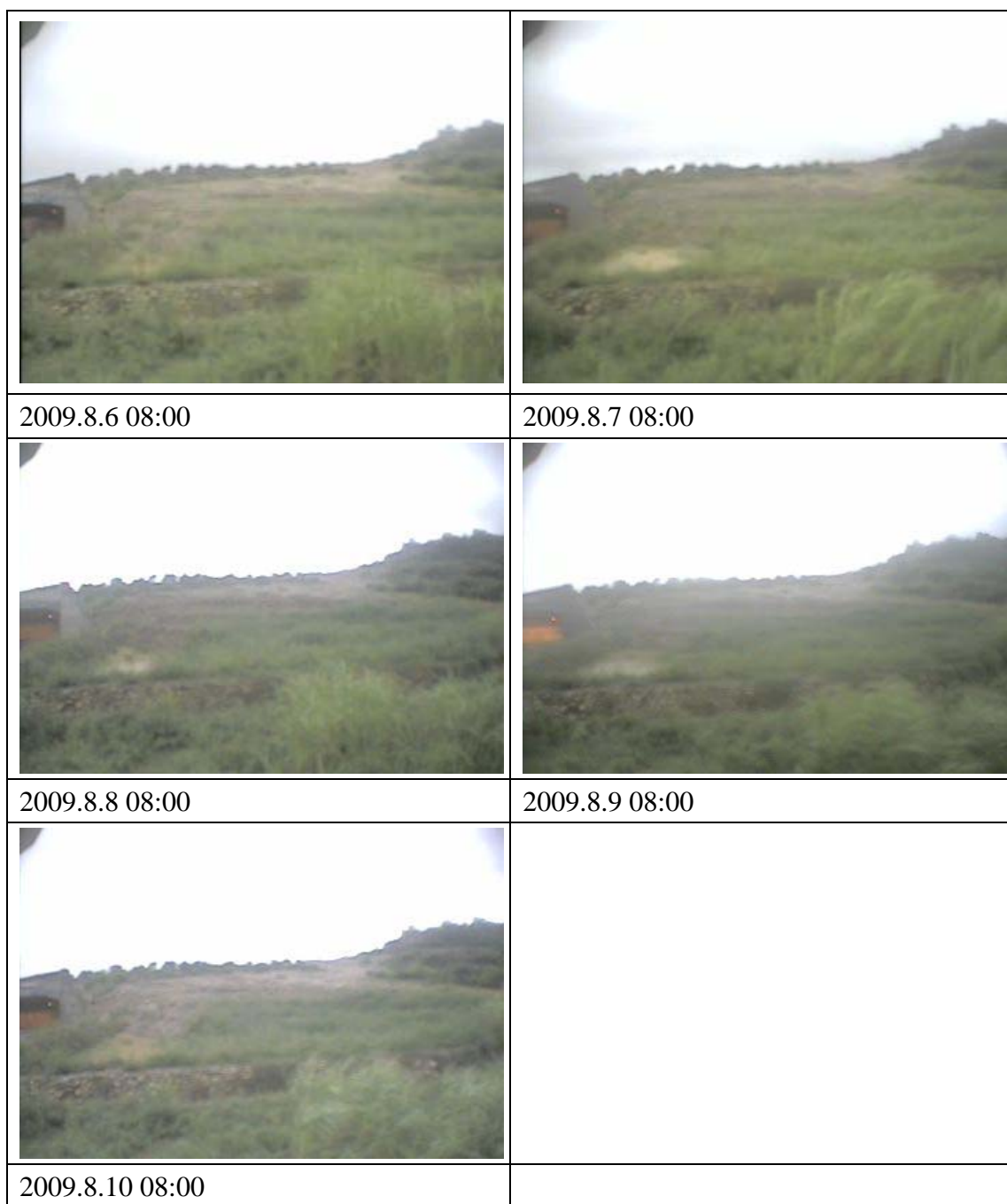
圖 34 8 月 6 日~10 日莫拉克颱風期間火炎山隧道東口影像監測圖
