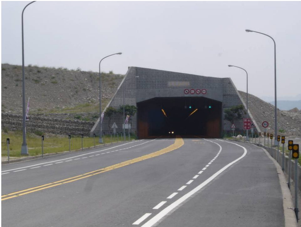
圖 8 完工後的火炎山隧道口（拍攝日期：2006/2/28）
