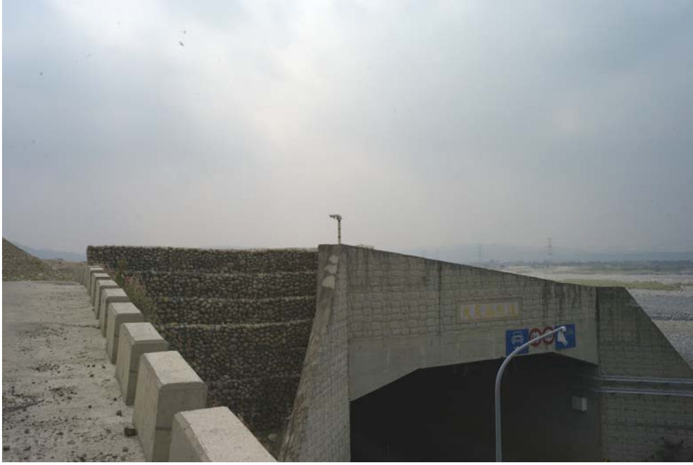
圖 46 本計畫在隧道西口設立的影像監視器
