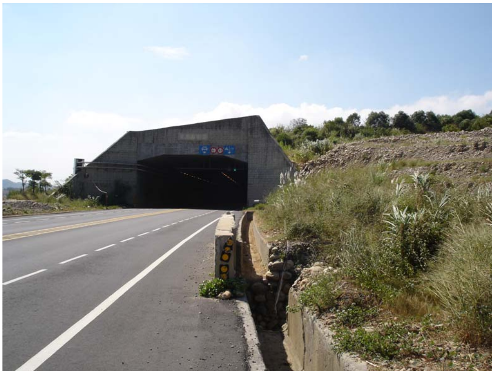
圖 52 莫拉克颱風後火炎山隧道東口情況 1
