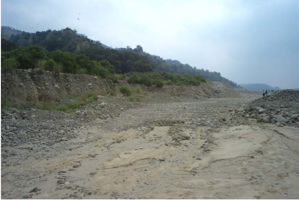
圖 48 從 5 號至 3 號集水區，沖積扇約被挖深 2 公尺
