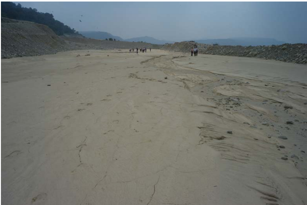
圖 49 下雨時細粒的泥沙被帶出，堆積在隧道上方
