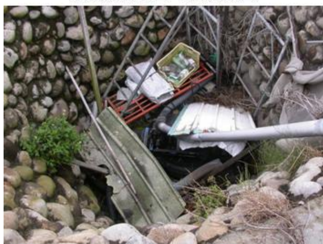
高灘地抽水井
