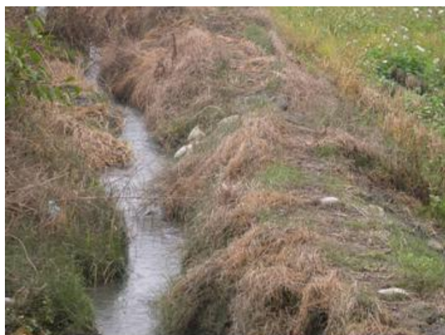
大安溪省道1河床渠道
