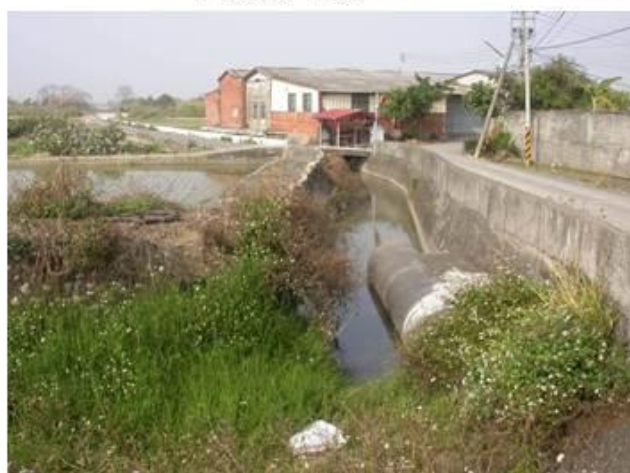
加禮橋下游溝渠
