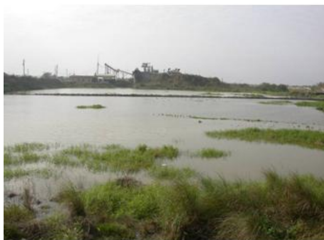
砂石場之沉沙池
