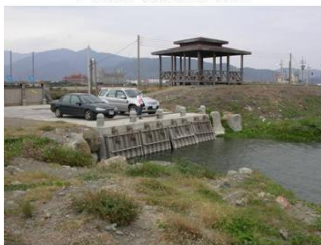
四重溪口西岸有閘門與涼亭
