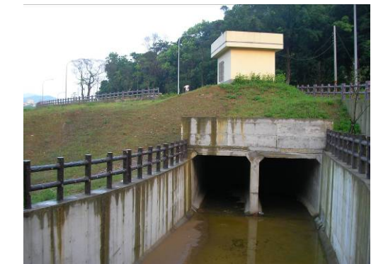
照片七 排水溝
