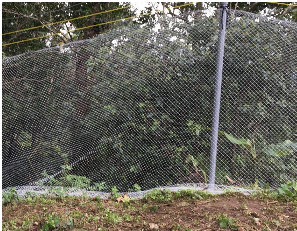
圖十、兩種設置電網用圍網 a.鐵網(或稱菱形網);b.塑膠軟網(或防鳥網)。
