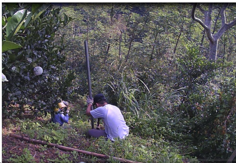
圖九、兩種設置電網用立柱 a.水泥柱;b.鋤管。
