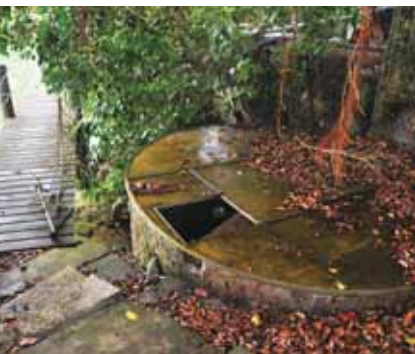
泉口已被水泥封住並加了鐵蓋。
