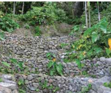
達悟人在山腳下，用傳統砌石法來保護山壁，避免土石流掩埋水源頭。
