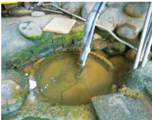
洗衣窟的水源頭設了抽水的水管。
