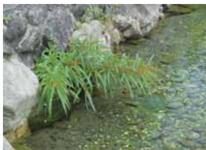
護岸完全水泥化，因此少見水生植物。
