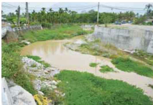
2013 年，施工後的「三合水」。
