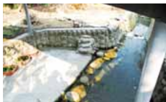
到處可見水泥化的洗衣坑。
