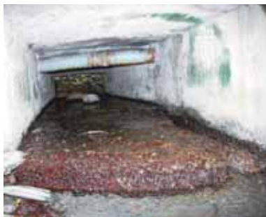
出水口位於馬路底下的涵洞。
