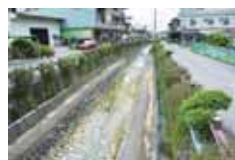
龍目社區內的水渠，污水分流在兩側。
