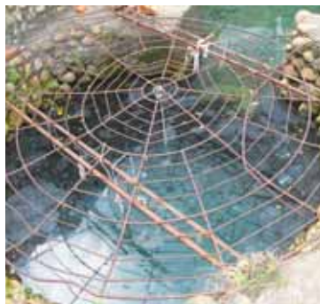
湧泉口為圓形井口，上方加設蜘蛛網狀鐵網。
