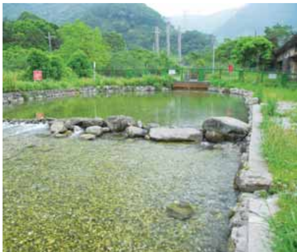
渠道較平緩部分，整治為遊憩區，供遊客泡腳、戲水。
