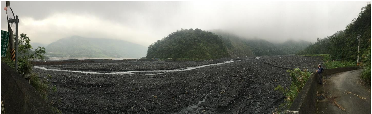
圖 3-18 蘭陽溪與土場溪匯流現貌
