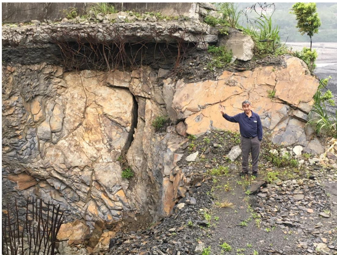
圖 3-2 廬山層清水湖段顯露於路基地下
