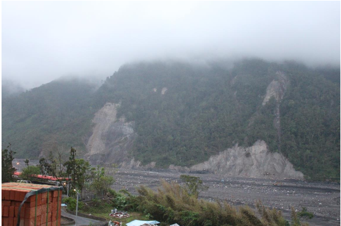
圖 3-19 蘭陽溪左岸崩塌處
