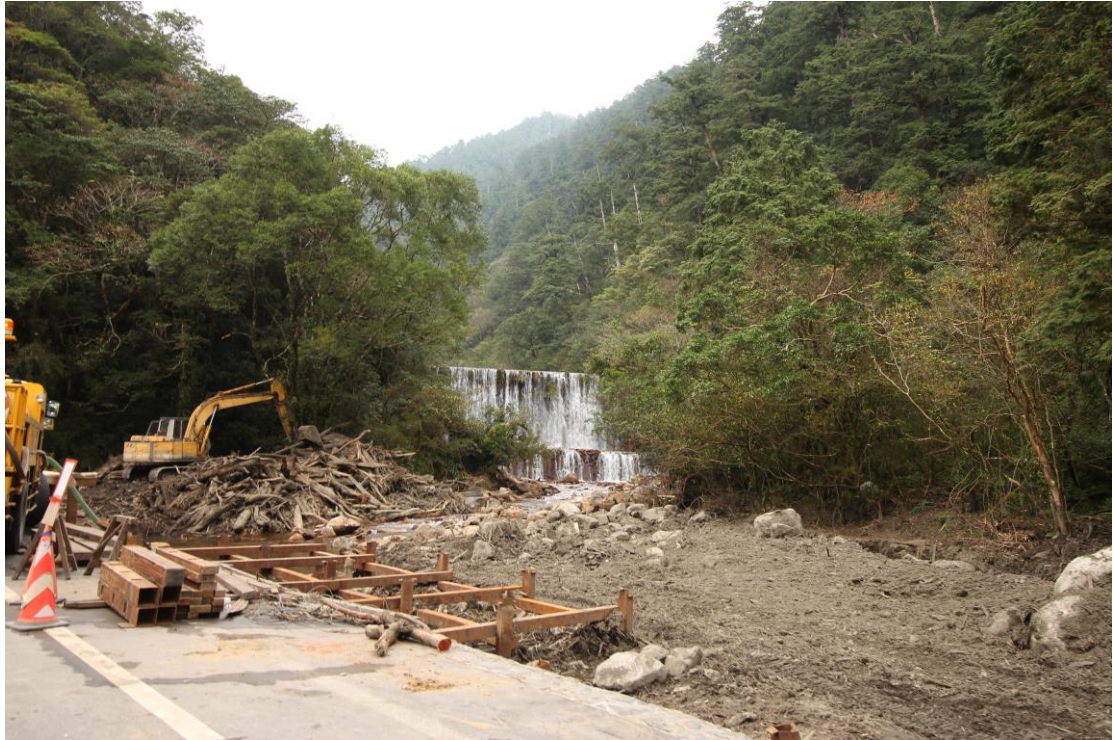
圖 3-4 三光溪上游進行河道工程整治中
