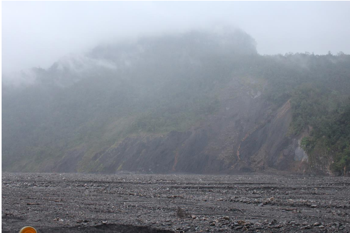
圖 3-17 蘭陽溪左岸之崩塌地
