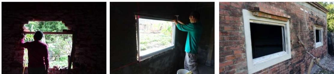
▲移除舊窗座後，窗楣換成水泥製，安裝鋁製氣密窗，並填補、修飾窗框四周。
