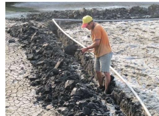
▲藉由生石灰遇水放熱的反應，達到殺菌的效果；將管線埋入地下
