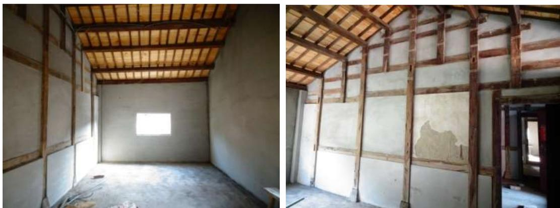
▲牆面粉光完成。其中，明間的隔間牆保留一區塊的竹編夾泥牆。
