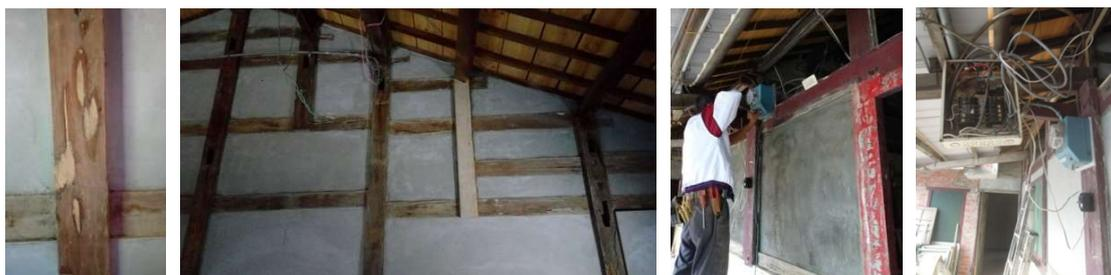
▲填補木結構坑洞，並加強蛀蝕嚴重之處的承重力。
