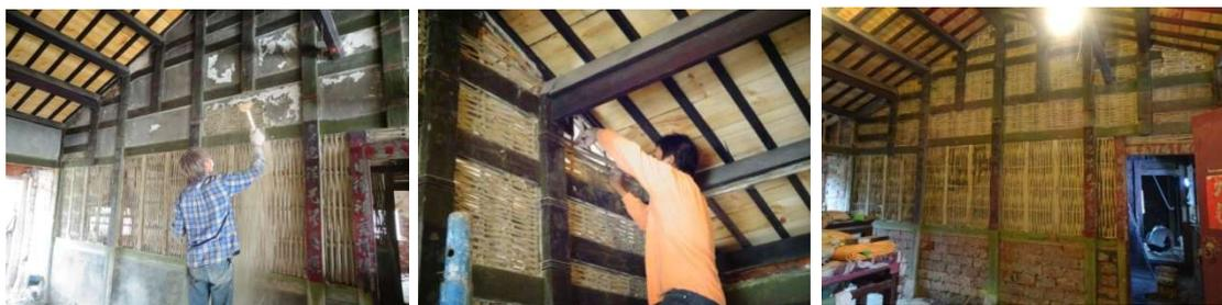
▲敲掉隔間牆表層的石灰後，重新整編竹編。
