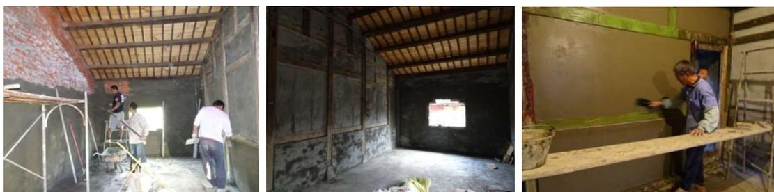
▲五開間內側牆面（包括隔間牆、磚牆）表層塗覆水泥，並粉光。
