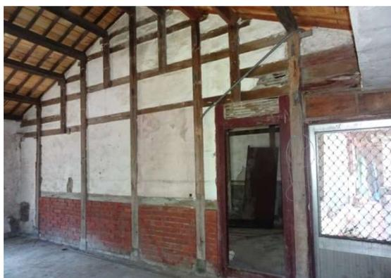
▲修繕前，隔間牆皆竹編夾泥牆，超過八成已剝落，前住戶僅以厚紙封住。
