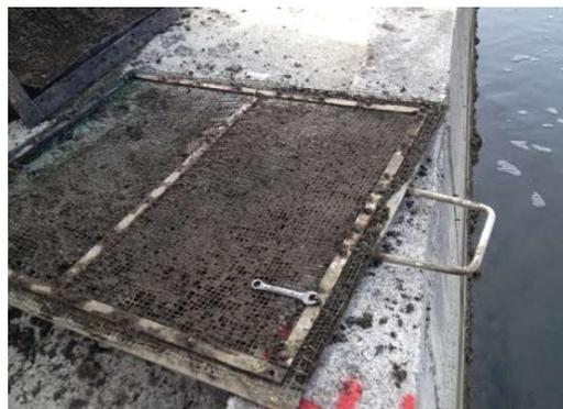
▲撈除龍鬚菜並耙除進水口附近的大量污泥，亦拆下破掉不再堪用的濾水網片
