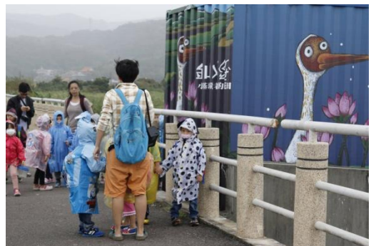
圖 80、圖 80-1. 小鶴貨櫃屋完工後
