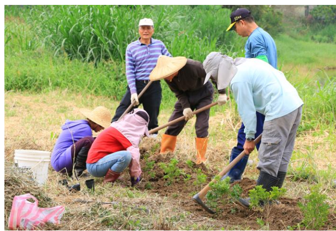
相片說明：濕地邊坡植栽種植
