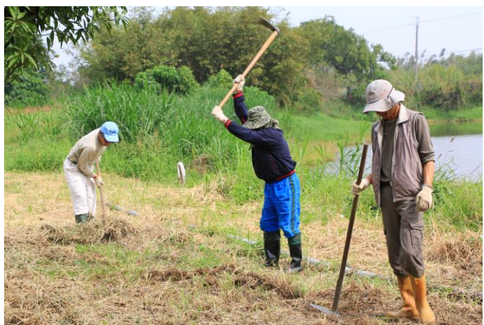
相片說明：濕地邊坡整地
