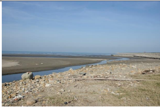
小飯壠溪出海口正好位於大潭專用港堤防背側，沙源容易受到海流侵蝕帶走，造成沙灘面積縮小
