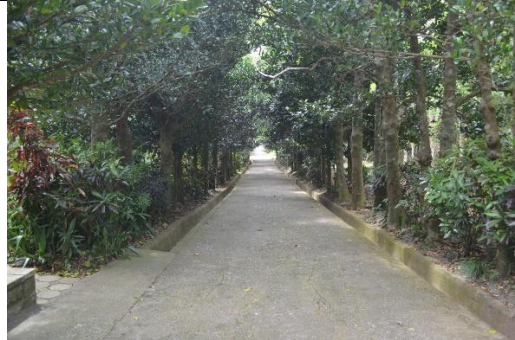
道路上的裂縫
