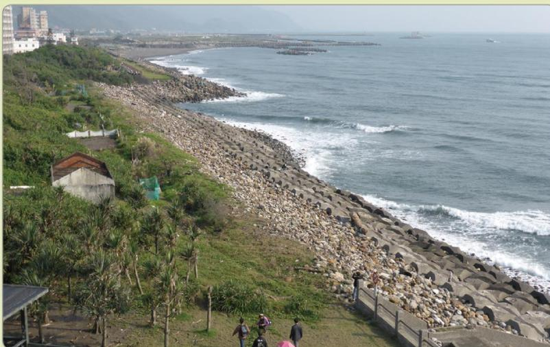
烏石港修築後，造成該港南側海岸後退加劇，除堆砌石塊外，外圍又用消波塊加以保護（攝於2013年11月17日）。
