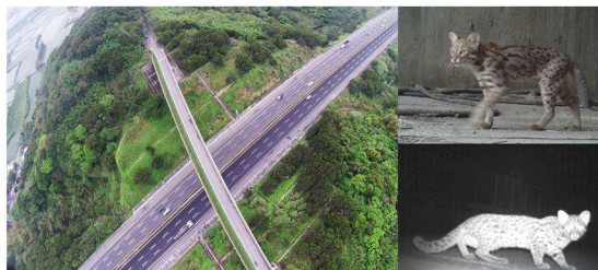
跨越式動物通道：通貫1號多功能跨越橋
