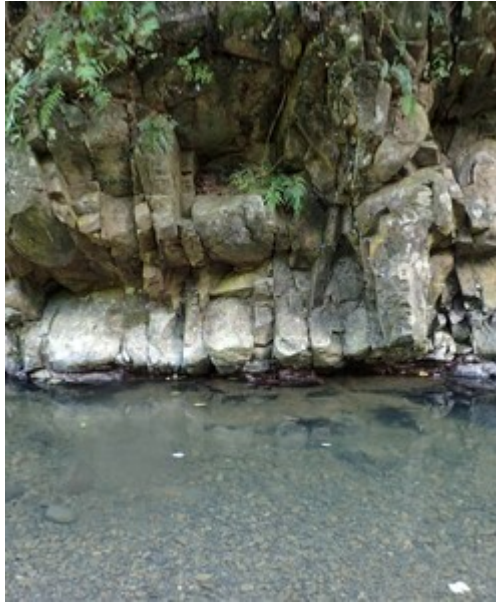
樹林覆蓋河岸有裂隙節理的石壁或土壁
