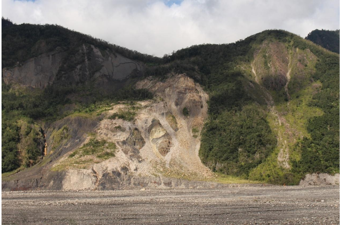
圖 3-3 留茂安溪附近崩塌地
