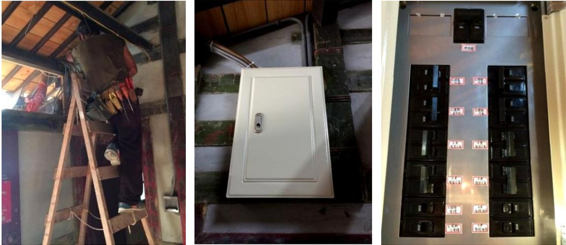
▲配置電線與設置迴路，同時完成配電箱及無熔絲開關的安裝，並針對各無熔絲開關標示迴路名稱。
