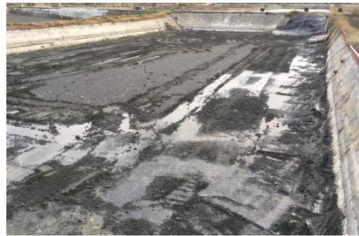
▲第一步驟製作完成的束井管線（圖左），待水抽乾土表乾裂後，便藉由怪手，將管線埋入約 30 呎深的池底（圖右）
