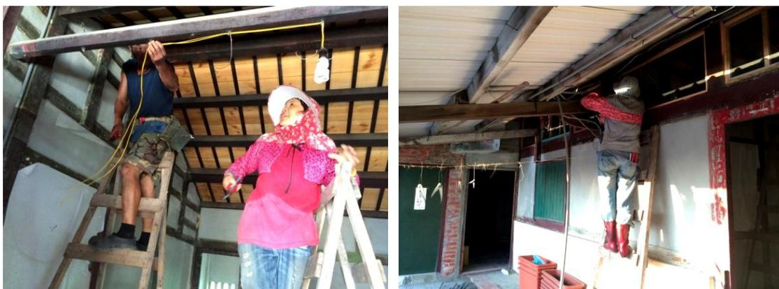
▲正身在配電前無任何照明用具及插座，運用此空間僅能使用臨時照明燈及延長線插座，此次施工前將臨時照明燈拆除，並妥善整理室內電線。
