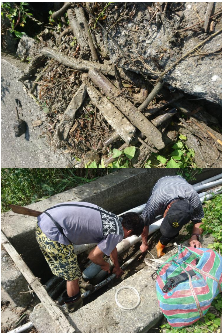
農耕期間管線因連續豪雨沖刷而損毀，由農民共同維修，通常當天需解決以免斷水影響稻米生長
