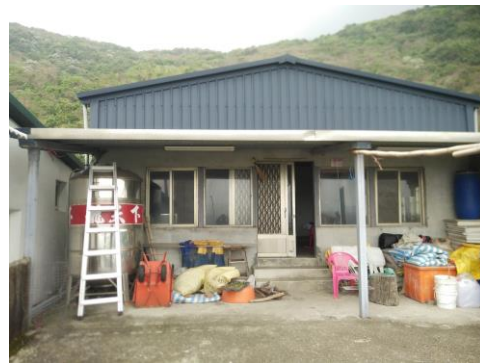
本年度增添 2 噸水塔，已可充足供水
