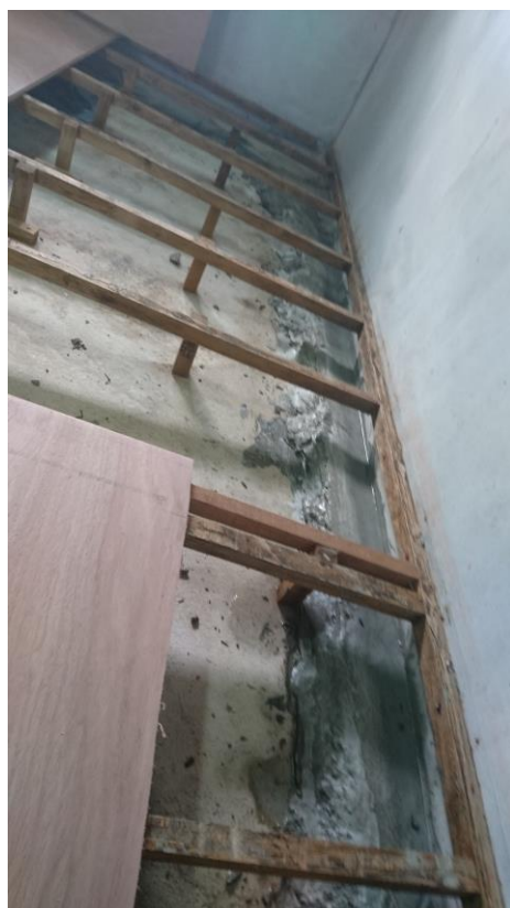
作四周水泥溝槽，以引導水流排出，避免溢流
