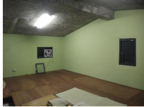
壁面抹平及防水、美化
