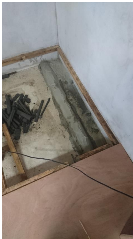
作四周水泥溝槽，以引導水流排出，避免溢流
