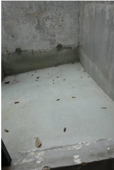
底部為斜面的多功能的籠舍，將排水塞住，水放少可飼養陸生動物，水放多則可飼養水棲性生物
