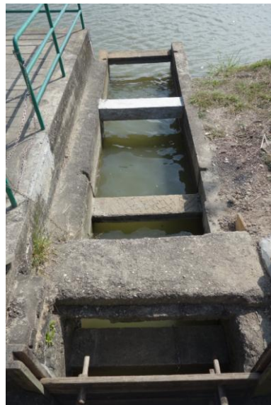
基圍調控水位的閘門
