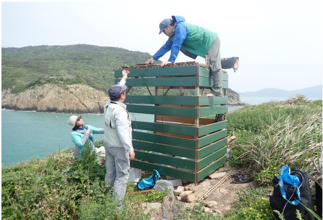
圖 6、於觀察小屋架設太陽能板供電給回播系統。
