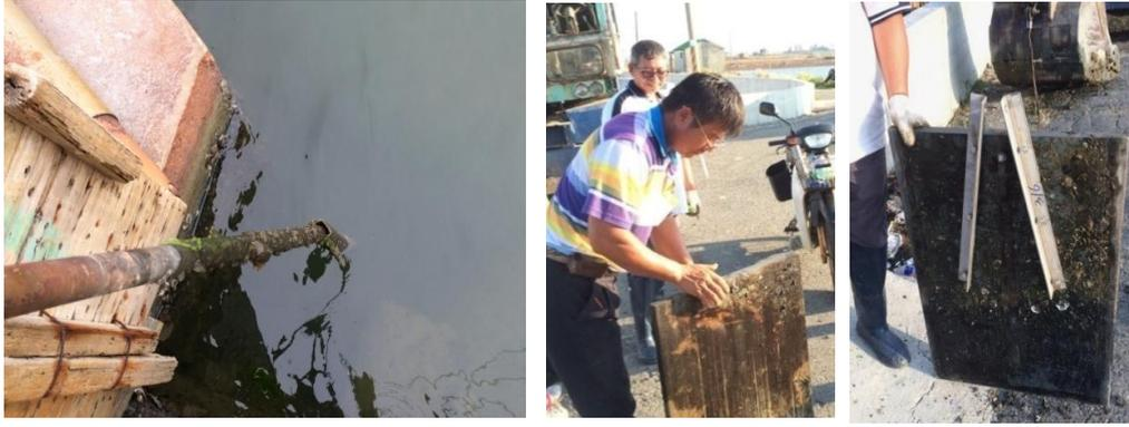
▲水門故障的原因是水門軸心與面板脫落，取出重新焊接後已可正常使用。
