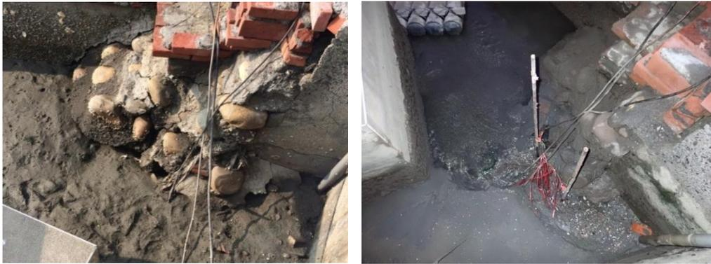
▲養水池進水口地基掏空處，滲水前正常乾燥(左)，開始出現滲水狀況後(右)終日有水。
