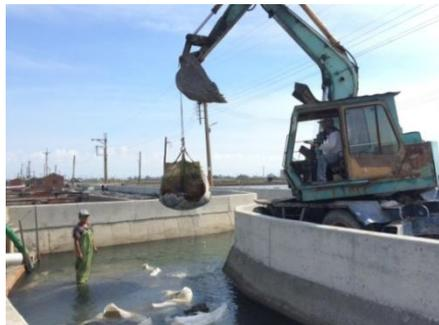
◀水門修繕前須先進行太空沙包的填堵作業、圍堵水門處，利用泵浦抽水後才能取出水門進行修繕。
