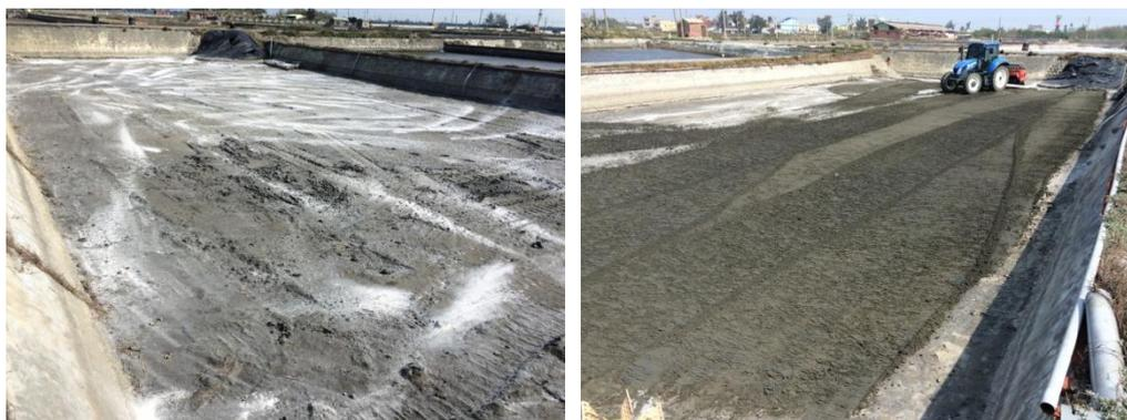
▲曳引機作業前將池子灑滿生石灰，透過曳引機將生石灰與上層土壤攪入下層，達到殺菌與鬆土的目的。
