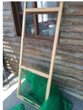
◀ 進水口木框經長年使用木框已斷裂，因此重新訂製過濾木框。
